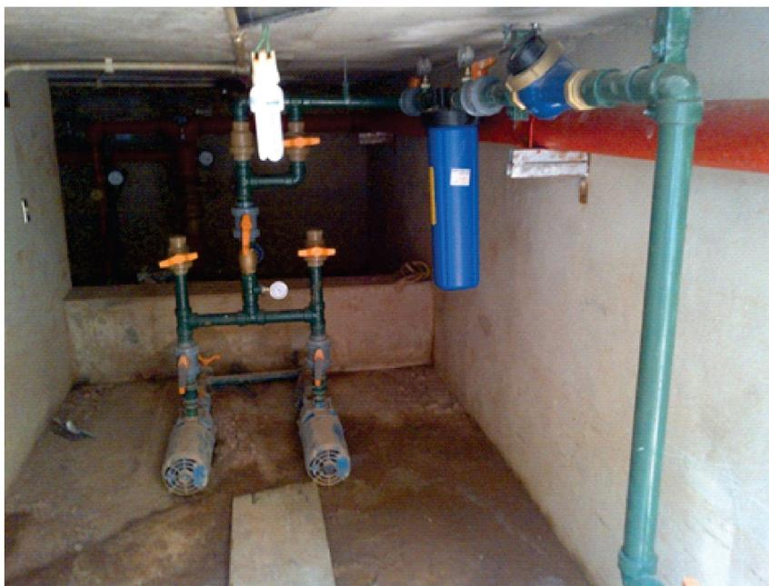
**Figura 5** – Sistema de bombeamento do reservatório de águas pluviais em SBC
