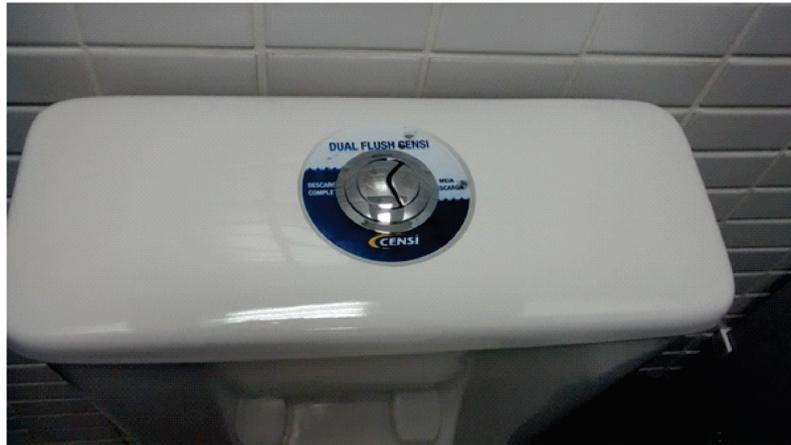
**Figura 9** – Sistema *dual-flush* instalado nos vasos sanitários da UFABC, com indicação de quando se economiza água (“meia descarga”) ou não (“descarga completa”)
